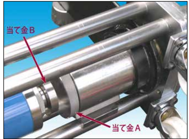
6, 油圧ポンプを作用させて、ブッシュを抜き取ります。
